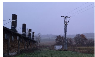
Anlagen der Bayernwerk Netz GmbH [VMB AG, 12/23]
