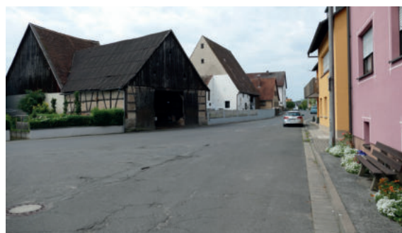
Abb. 55: Mangelhafte Gehwege und unübersichtlicher Straßenraum
